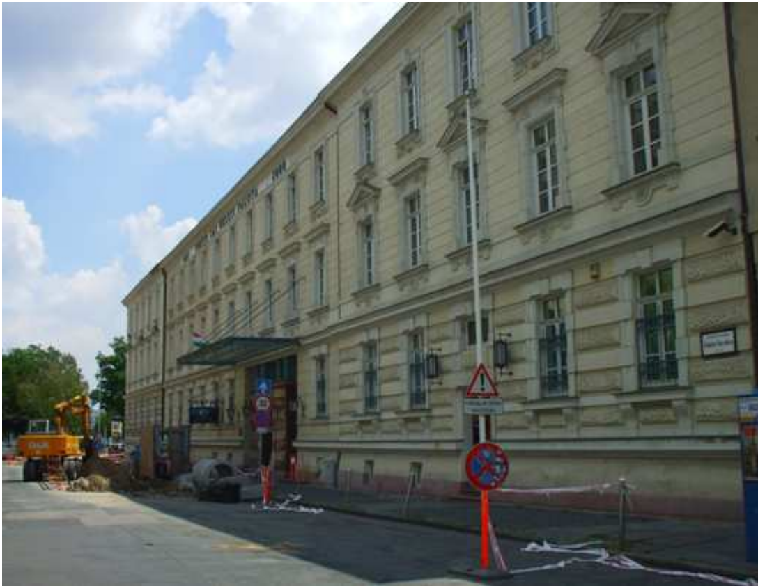
A Fekete Sas utcai (felújított) homlokzat
